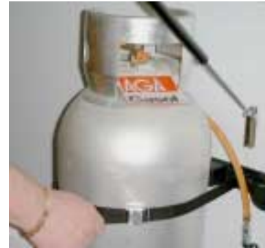
Var noga med att gasolbehållaren är ordentligt fastspänd.
